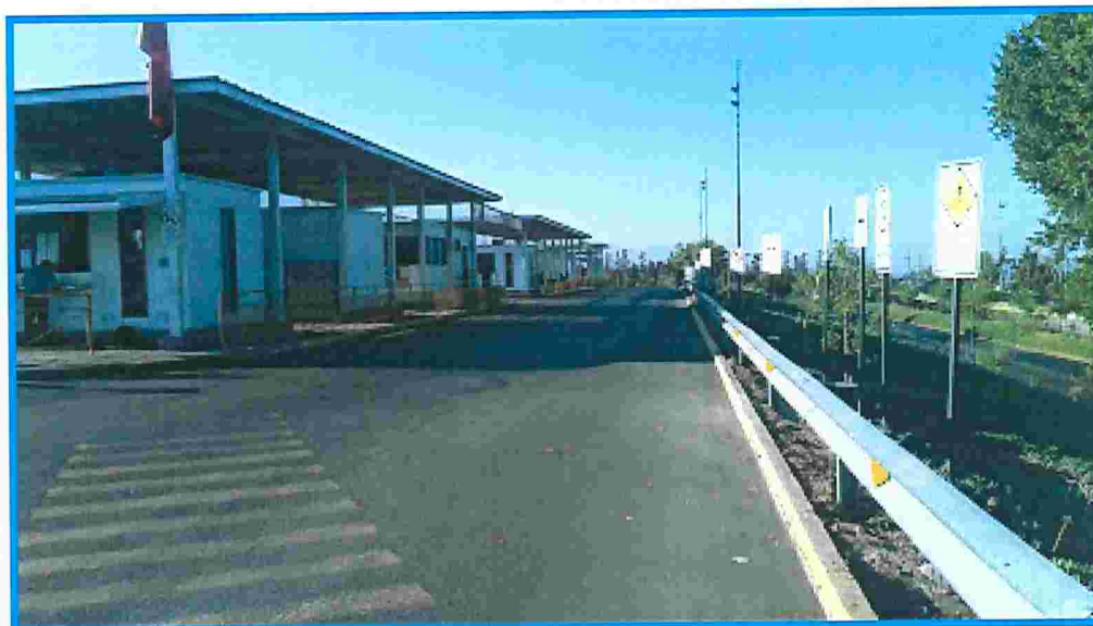
Fotografía N°15: Terminal de Buses de Transantiago
