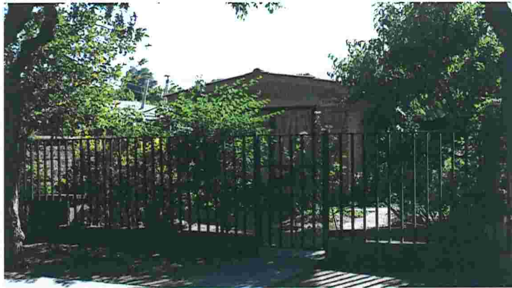
Fotografía N°1: Tipo de Vivienda Unión de Cooperativas.
