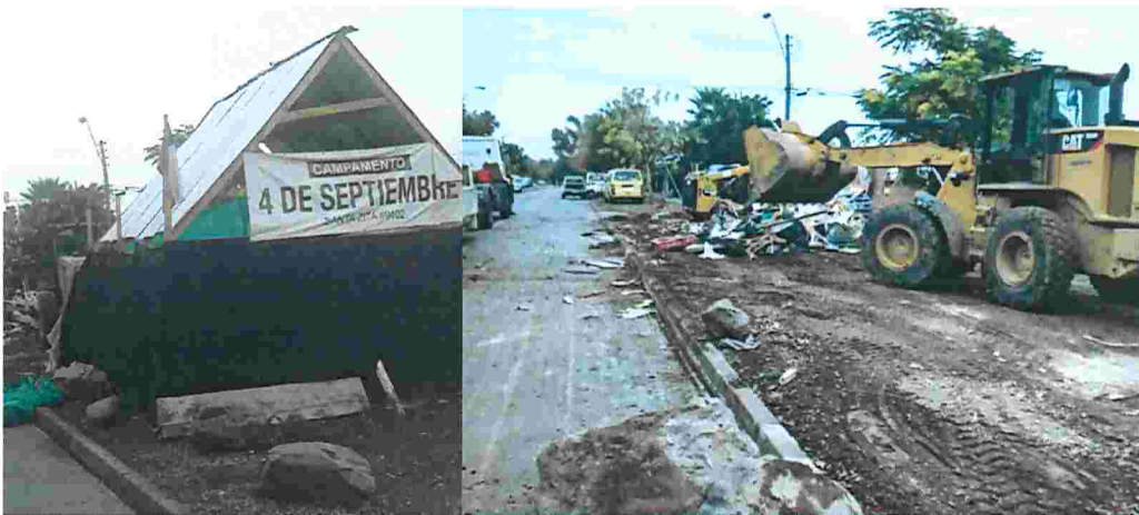
Fotografía N°2: Campamento 4 de Septiembre
